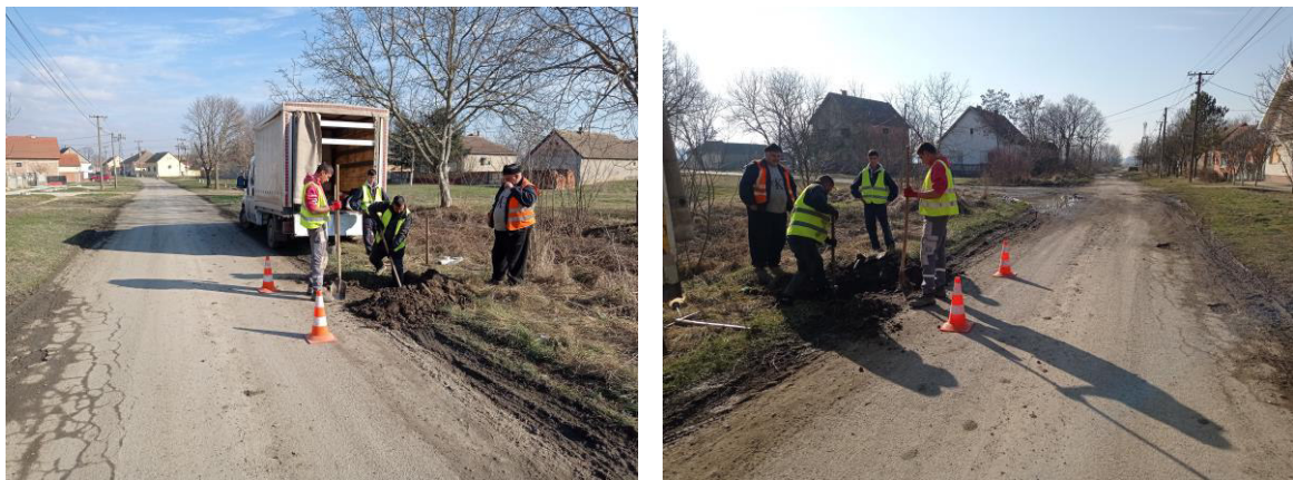
Slika 3. Lokacija iskopa istražne jame IJ-01
