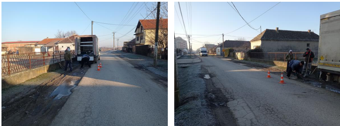
Slika 3. Lokacija iskopa istražne jame IJ-01
