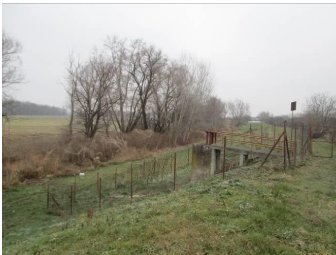
Слика 11 и 12: Цестасти испуст за атмосферску воду са табластим затварачем
