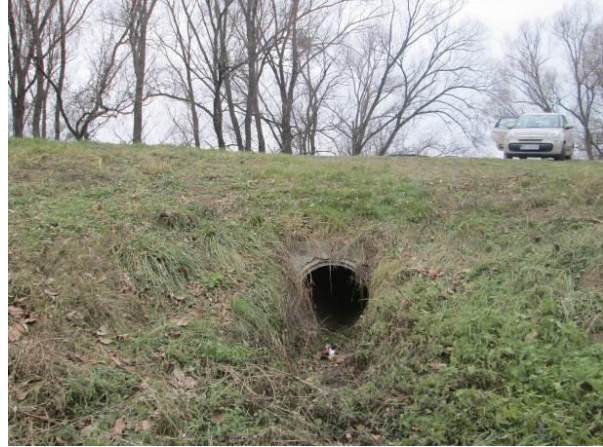
Слика 14: Изглед испуста км 8+181
