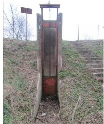
Слика 11 и 12: Цестасти испуст за атмосферску воду са табластим затварачем
